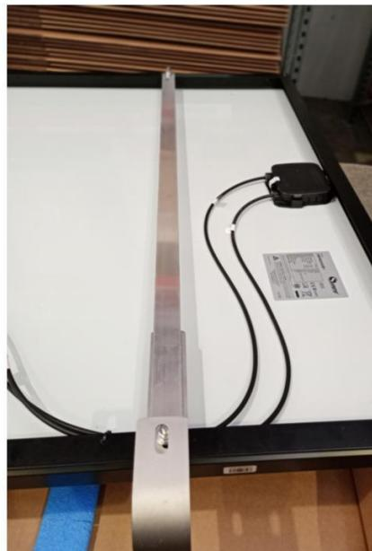
Fissare le due staffe telescopiche, la parte a L, sulla parte inferiore del pannello sui fori già predisposti
