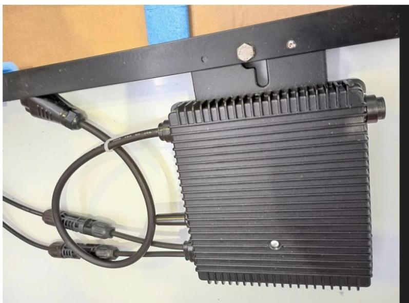
Fissare il Micro Inverter al telaio di uno dei due moduli con apposito Bullone a foro già presente su telaio modulo, inserire poi vite di sicurezza come indicato in foto (di norma questa operazione viene fatta direttamente dal costruttore).
